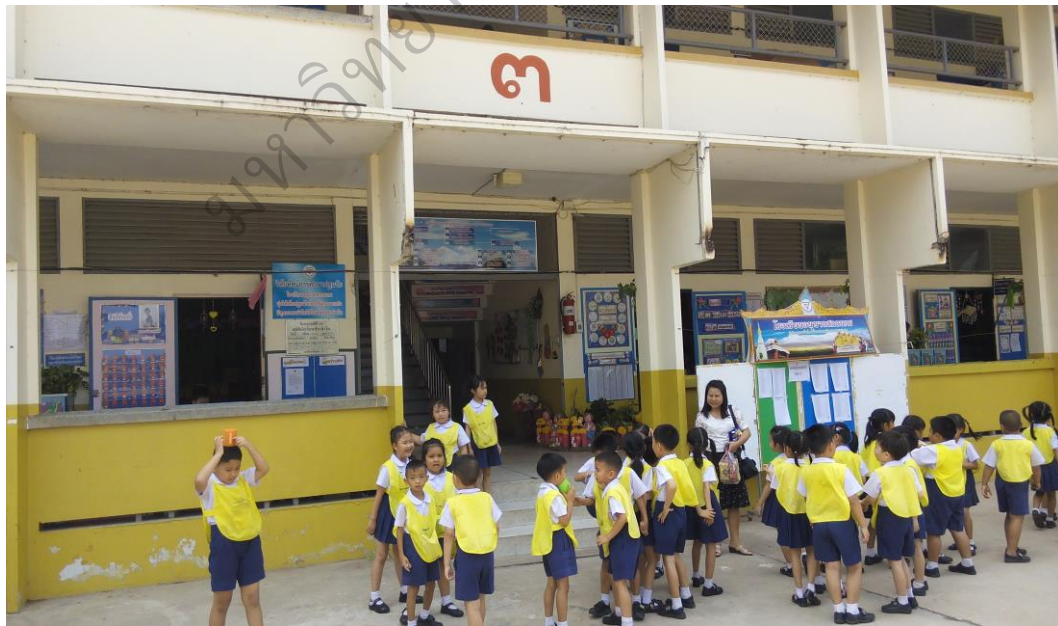
สภาพด้านหน้าอาคารเรียนโรงเรียนอนุบาลสกนคร
