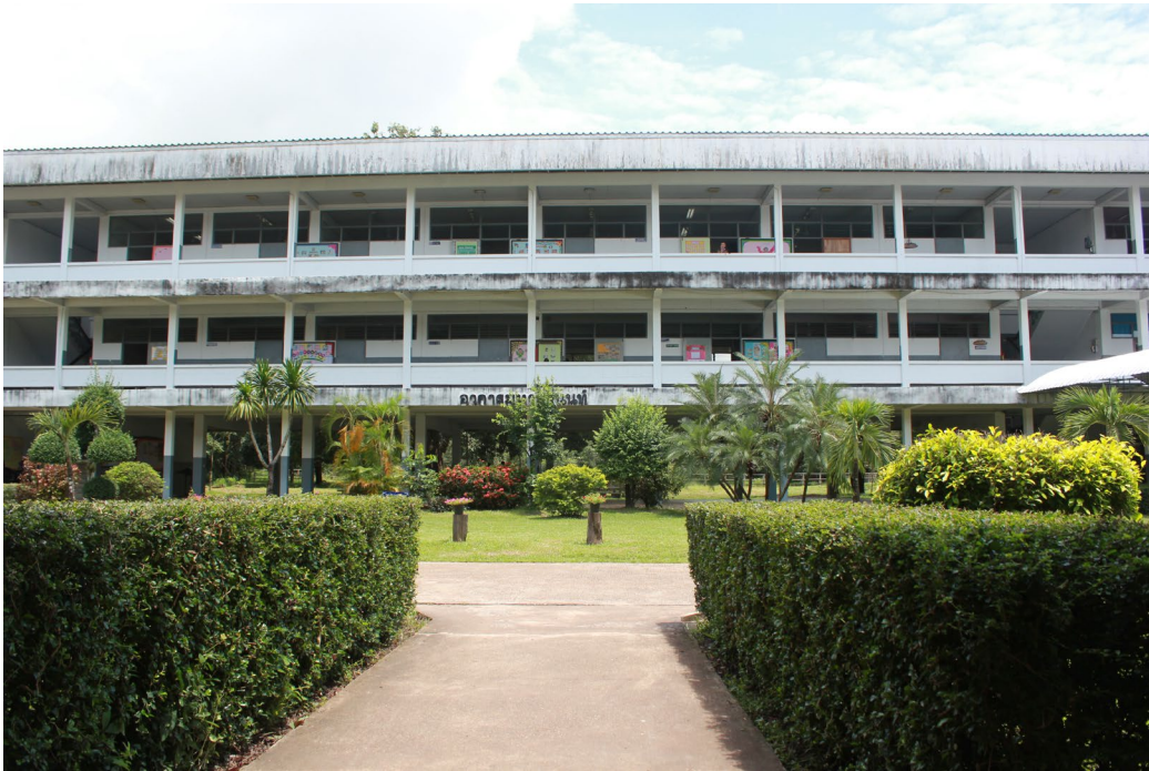
ภาพประกอบ 5 ก่อนการบริหารจัดการงานอาคารสถานที่และสิ่งแวดล้อม (ตัวอาคาร)
