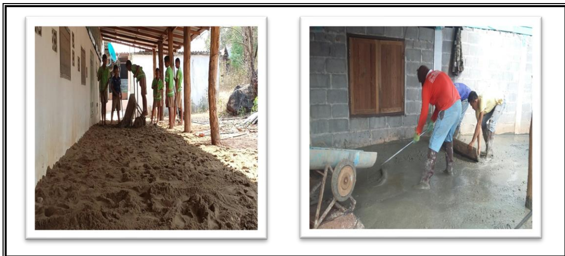
ภาพประกอบ 15 การปรับปรุงใต้ถุนอาคารเรียน
