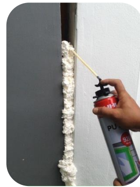
โฟมสเปรย์อุดรูรั่ว ผลิตจากพอลิยูรีเทน จัดเป็นพลาสติกเทอร์มอเซต
